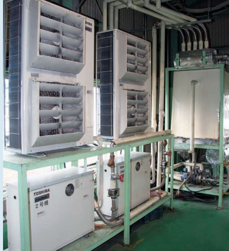
▲ 乾燥工程の熱源(電気ヒーター)による消費電力の増大を改善するため、既存の補助熱源として電気式ヒートポンプ「CAONS140(4台)」が設置された
